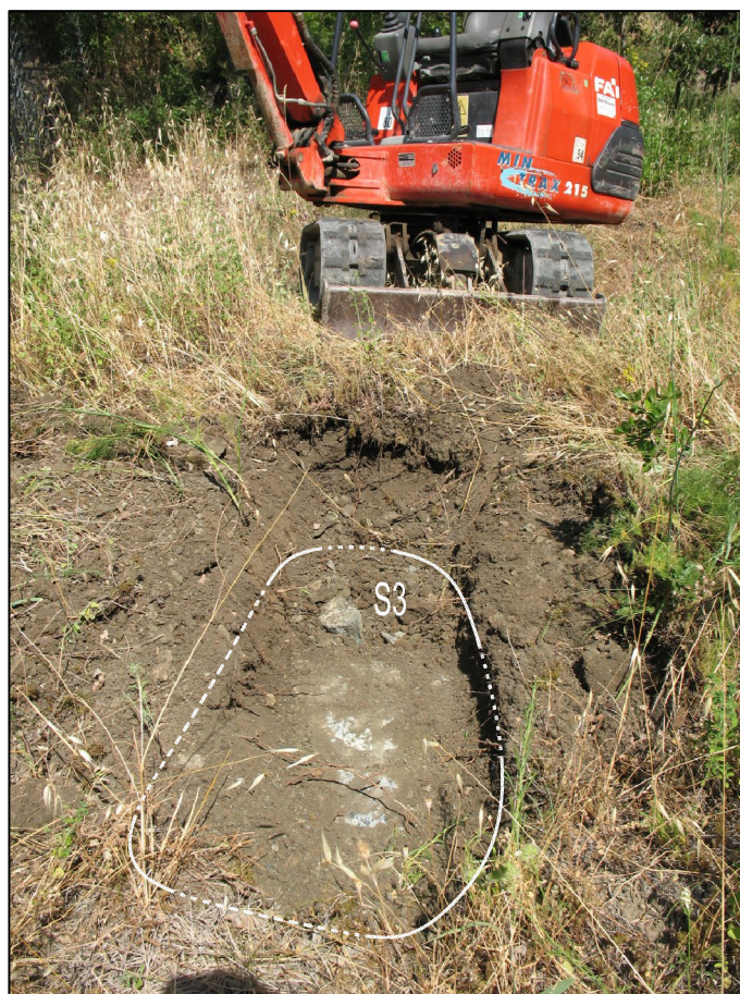
Scavo S3. E' evidente l'effetto della benna sulla roccia a breve profondità.
